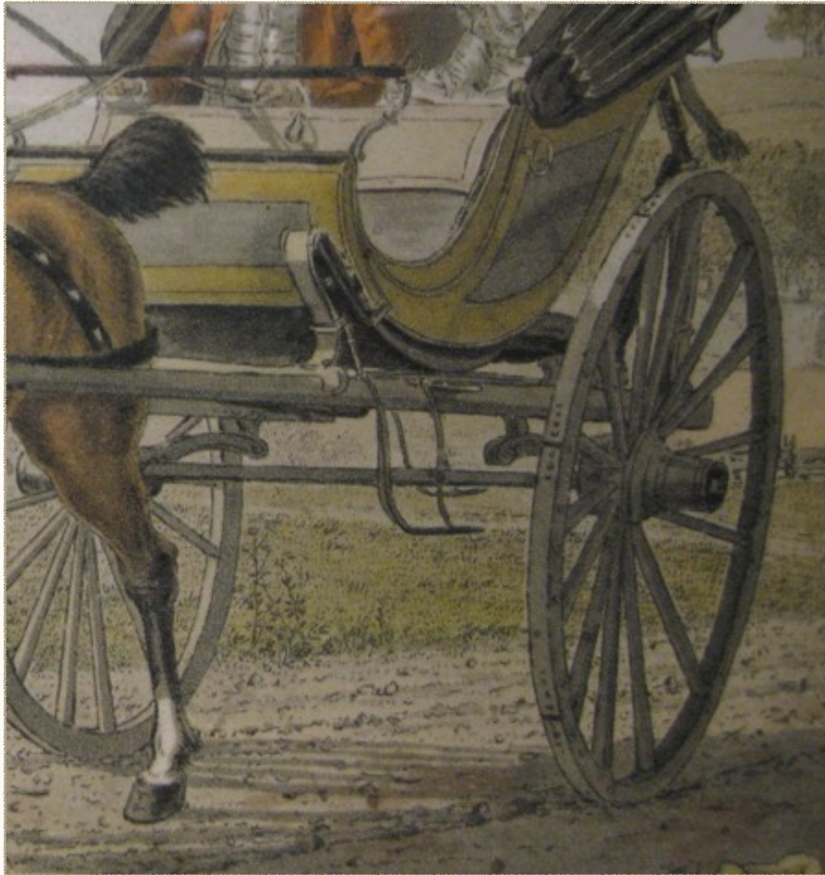
Abb. 44 Zweirädrige Chaise aus der Schweiz der Zeit um 1800 mit unter dem Kasten durchlaufenden Tragriemen nach einem zeitgenössischen Aquarell. Dieses Beispiel zeigt eine Konstruktion mittels Eisenarmen, die die nötige Distanz zwischen den Gabelbäumen und dem Auflagepunkt der Tragriemen herstellen.
