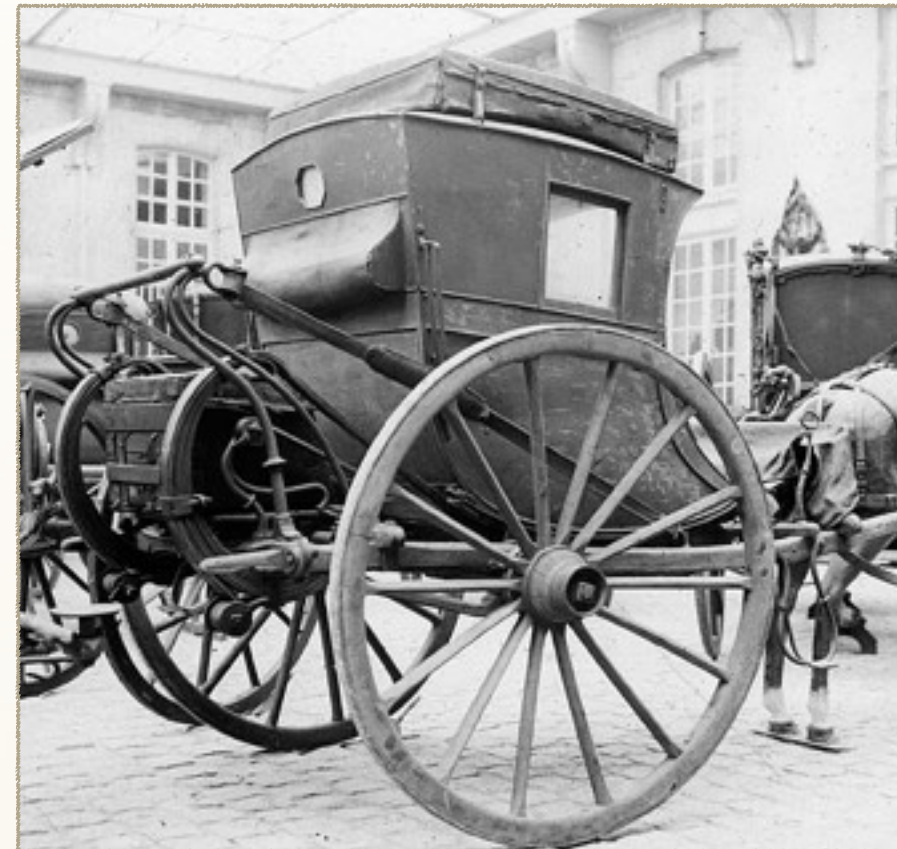
Abb. 41 Französische Postchaise des frühen 19. Jahrhundert im Nationalmuseum für Wagen und Tourismus in Compiègne als Beispiel für über C-Federn aus Stahl laufenden Tragriemen und stabilisierenden Seitenriemen.
