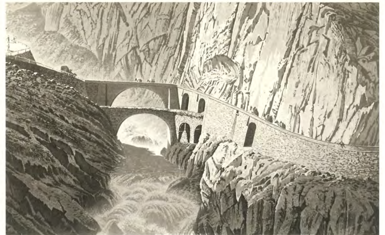
M. Külin aut. nat. del. et sc. Vue du nouveau, et de l'ancien pont. dit du Diable.
