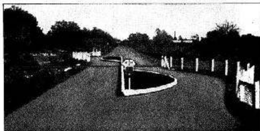
Schutz für Automobilisten an Bahnübergängen. In St. Pauli Fallstraße in Florida hat eine Vermeidung von Unfällen an Bahnübergängen die Landstraße an beiden Seiten der Gleise eine halbbarometrische Kassenmauer dergestalt, so daß der Fahrer nicht im schnellsten Tempo geradlinig fahren kann, sondern sein ganzes Augenmerk auf dieses Hindernis legen muß. (Atlantic-Union Co.)
