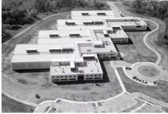
Das Vorbild zum neuen Sammlungszentrum in Affoltern am Albis, das 1983 eröffnete „Museum Support Center“ der Smithsonian Institution in Suitland (MD).
