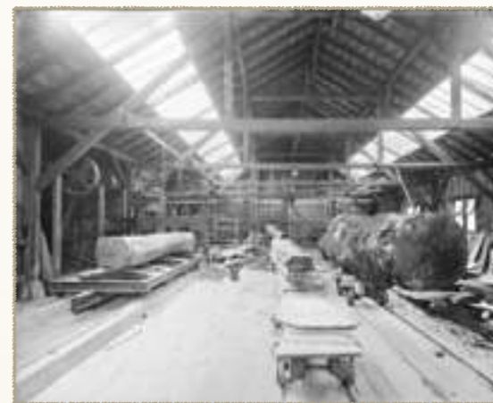
Abb. 19 1896 in Betrieb genommene Sägerei der Firma Geissberger in Schlieren. Hier im Zustand von circa 1910/20. (Historic Schlieren)
