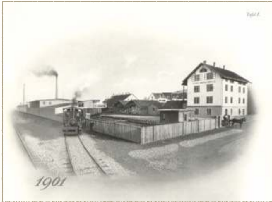
Abb. 22 Zustand der Fabrik in Schlieren im Jahre 1901.
