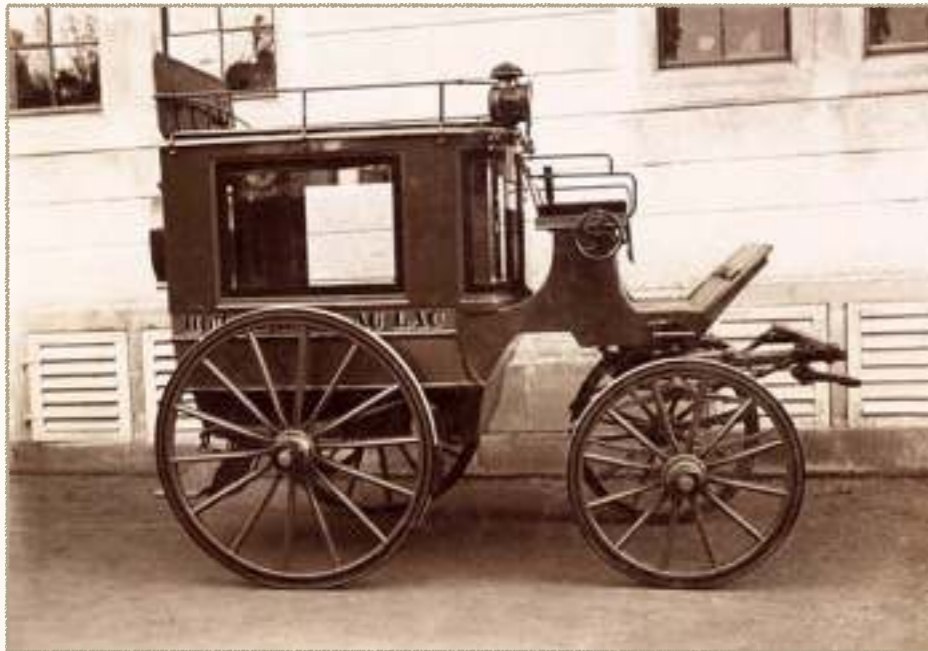
Kleinerer Omnibus für das Hotel Baur au Lac in Zürich. Der innen vierplätzig Wagen wurde ebenso aufwändig gebaut und ausgestattet wie ein Privatwagen. Originalabzug von Geissberger.
