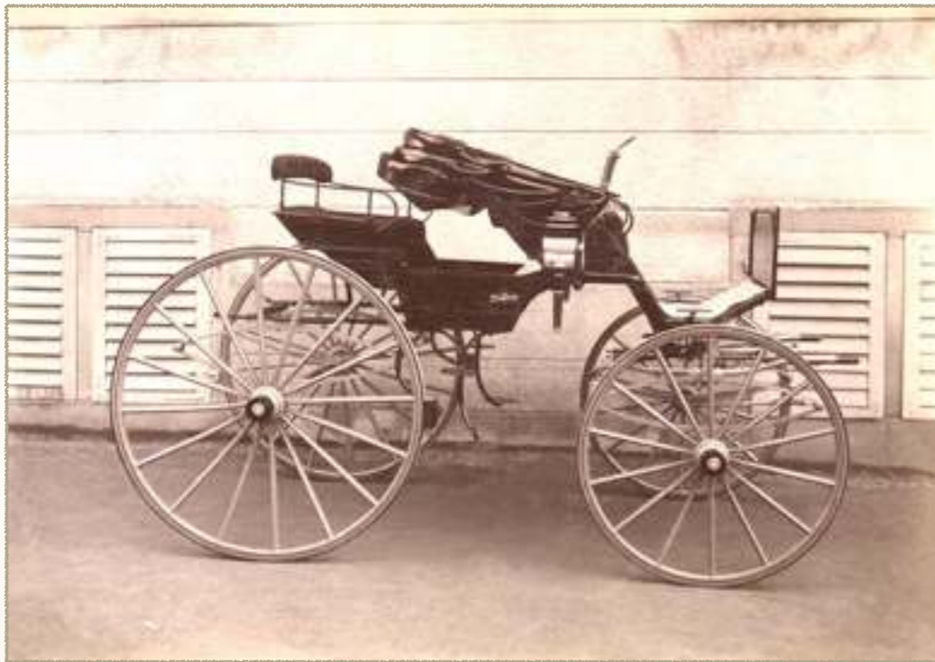
Siamesen-Phaëton, oben ohne und unten mit eingestecktem Halbverdeck. Originalabzug von Geissberger des Wagens von S. 150. Dank der Notiz auf der Rückseite dieser Photographie wissen wir, wie das Modell von Geissberger genannt wurde, nämlich „Americaine“. Auf der Rückseite steht auch „Verdeck zum Wegnehmen“.
